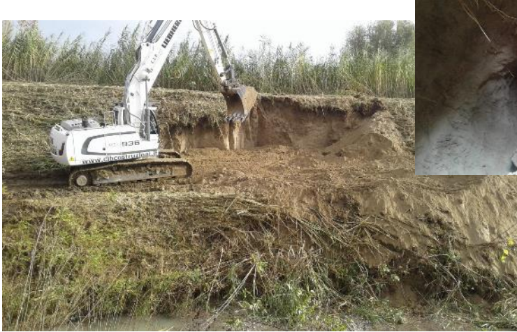
Ricostruzione arginatura danneggiata da animali fossori – t. Lavino loc. Prati
